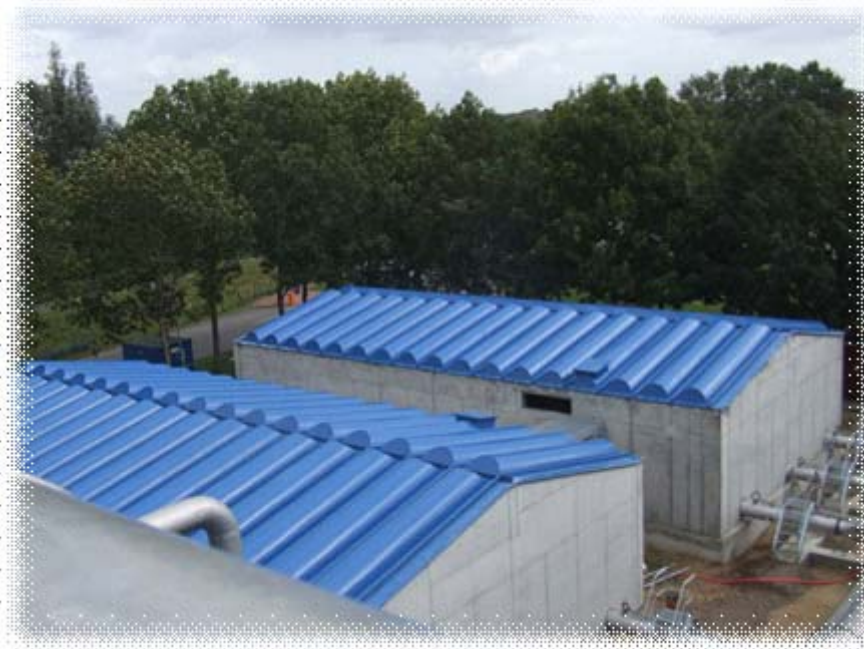
Slika 3.5. Primjer ugrađenog pokrova od GRP elemenata
